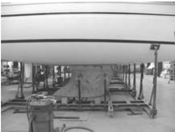
plaatsen van de kielen
